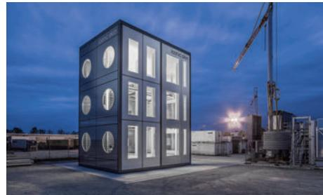
Das Versuchsgebäude iconic skin ist ein Prototyp und ermöglicht umfangreiche Langzeittests. Le bâtiment-test iconic skin est un prototype qui permet d'effectuer de nombreux tests de longue durée.
