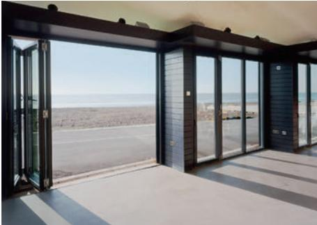
Die Flügel der Glas-Faltwände sind mit Dreh- bzw. Dreh-Kippflügeln ausgestattet. Die verdeckt liegenden Beschläge mit Einhandbedienung ermöglichen eine gleitende Verriegelung für teilgeöffnete Glas-Faltwände.
