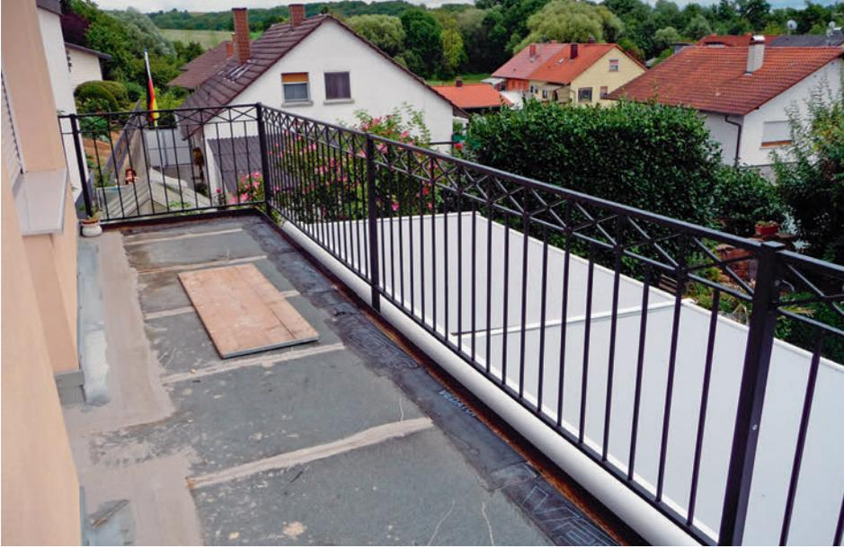
Das Geländer macht schon ohne genaue Prüfung einen sehr instabilen Eindruck. Der Pfostenabstand ist mit 2,66 m eindeutig zu gross.
