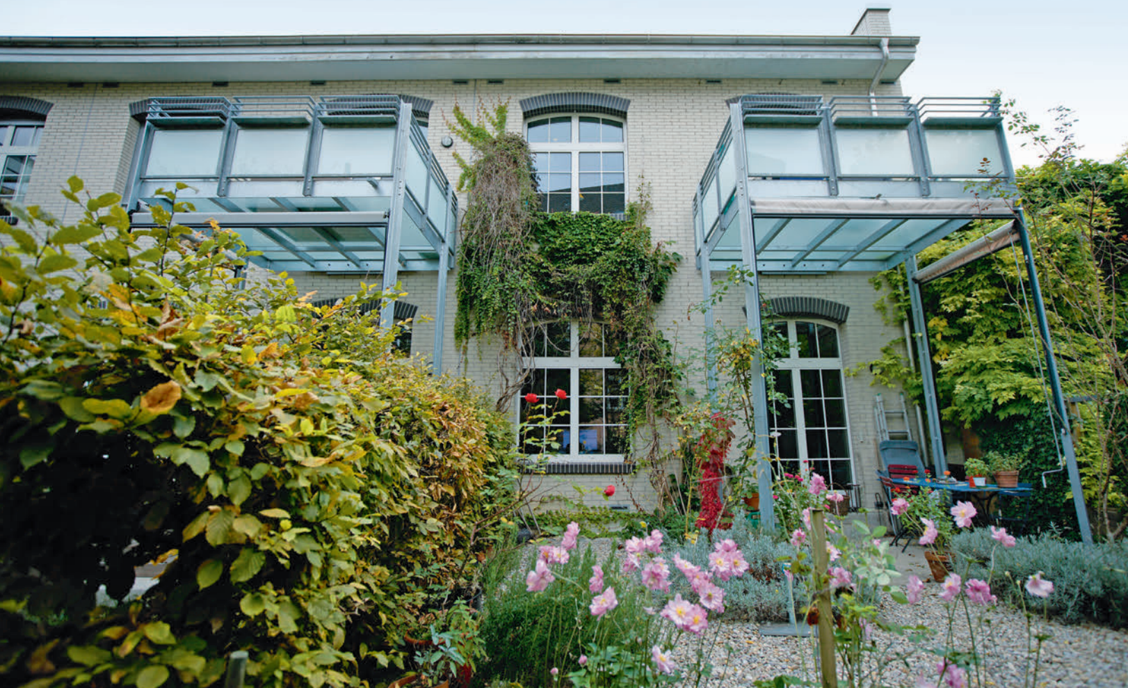
Gebaut vor 1920: anpassen heisst sich einpassen, ohne die eigene Note zu negieren. Construit avant 1920 : ajouter, c'est s'adapter, sans oublier la touche personnelle.
