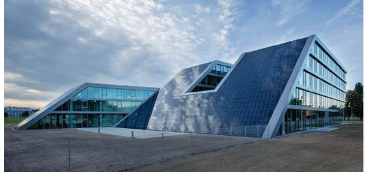
von hochtechnisierten Materialien der Gebäudehülle (z.B. 3-fach-Verglasung mit Sonnenschutzfolie), einer regenerativen Technik und einer
