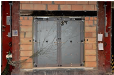
Die Tür ist im Brandofen eingebaut und bereit für den Test.
