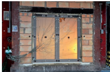
Über die gesamte Prüfdauer wird an zahlreichen Messpunkten die Oberflächentemperatur protokolliert.
