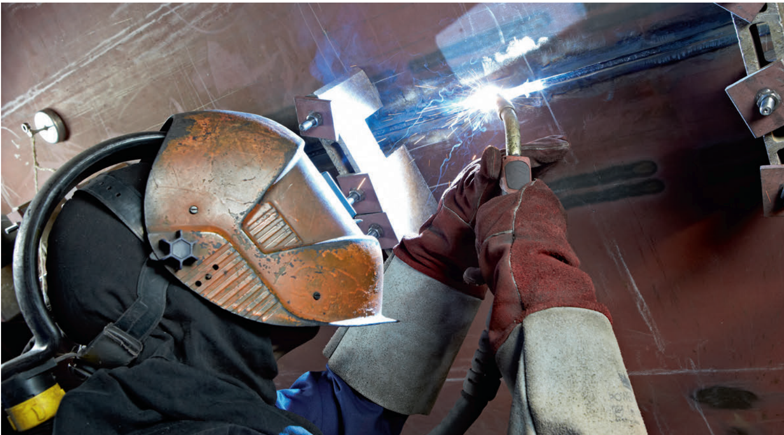
Die Schweißer bei SLOB nutzen beim Bau der Schiffsrumpfe mit nur einer Ausnahme alle verfügbaren Schweißpositionen.
