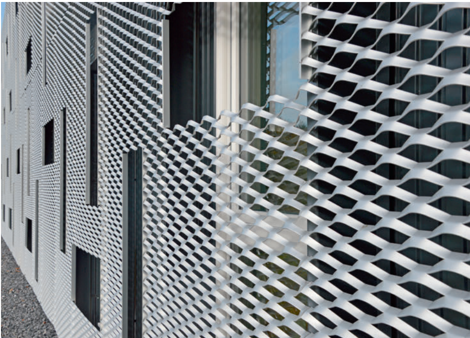
Fassade mit Blechschutz bei Fensteraussparung.
