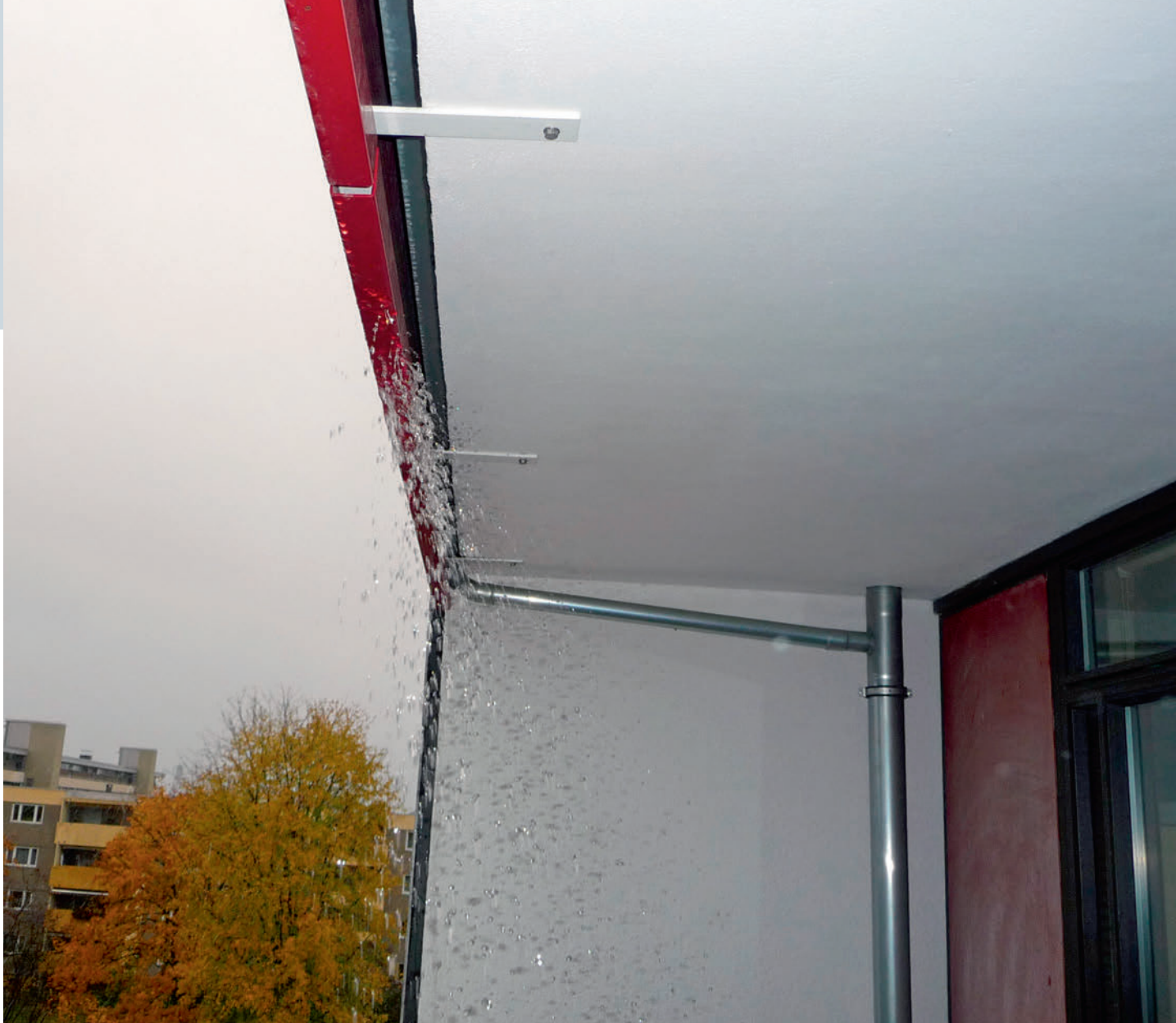
Der Beregnungsversuch entspricht einem Starkregen. Hier wird das Wasser an der Unterkante des Geländers abgelenkt. Le test d'arrosage représente l'équivalent de fortes pluies. L'eau est ici déviée vers le bord inférieur de la balustrade.
