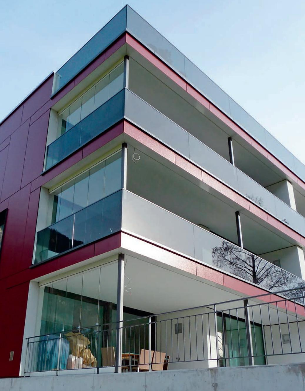
Durch die Verwendung von DuPont™ SentryGlas® Ionoplast Interlayer hat vetroSafe Plus entscheidende Vorteile gegenüber vetroSafe mit PVB-Verbundzwischenlagen.
