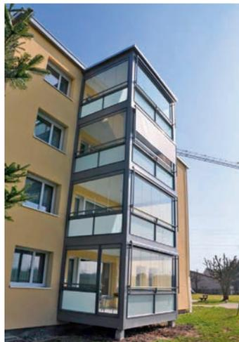
Das System mit Integralrahmen ist so konstruiert, dass sämtliche Belastungen durch den oberen und unteren Rahmen der Elemente aufgenommen werden.
