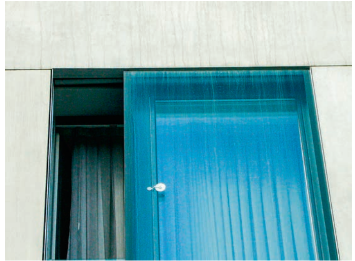
Abbildung 4 Ansicht Vorverglasung mit Aufschichtungen von Alkalibestandteilen (Praxisbeispiel 2).
