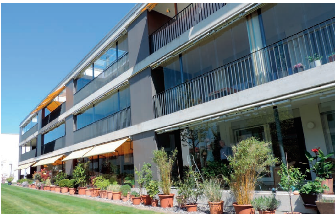
Abbildung 2 Fassadenansicht Sitzplatz- bzw. Balkonverglasungen (Praxisbeispiel 1).
