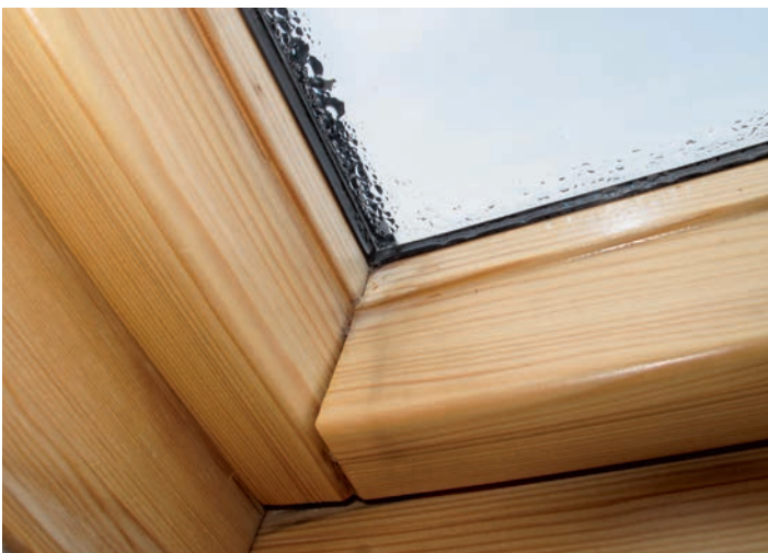
Das Randverbundsystem ACSplus verhindert Kondensatbildung. Le système d'assemblage périphérique ACSplus empêche la condensation.
