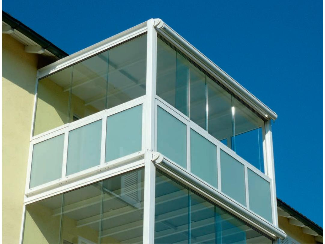
Ein Balkon komplett aus Metallbauer-Hand. Balkonbodenplatten sind leichter als Beton und einfach zu verarbeiten.
