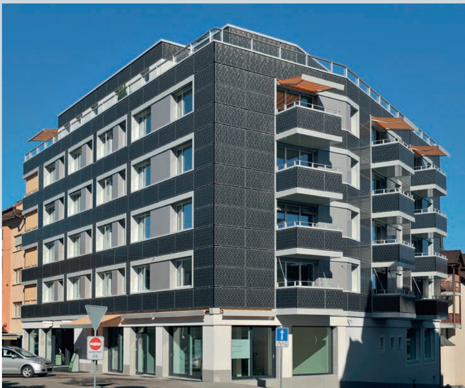
Das sanierte Gebäude mit der neuen energieproduzierenden Fassade. Heizenergiebedarf 9,1 kWh/m 2 a. Bâtiment rénové et sa nouvelle façade productrice d'énergie. Besoins énergétiques pour le chauffage : 9,1 kWh/m 2 a.
