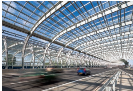
Die gläserne Einhausung ist 1200 Meter lang; alle 200 Meter befindet sich ein Notausgang. Ce tunnel vitré est long de 1200 m ; des sorties de secours sont prévues tous les 200 m.
