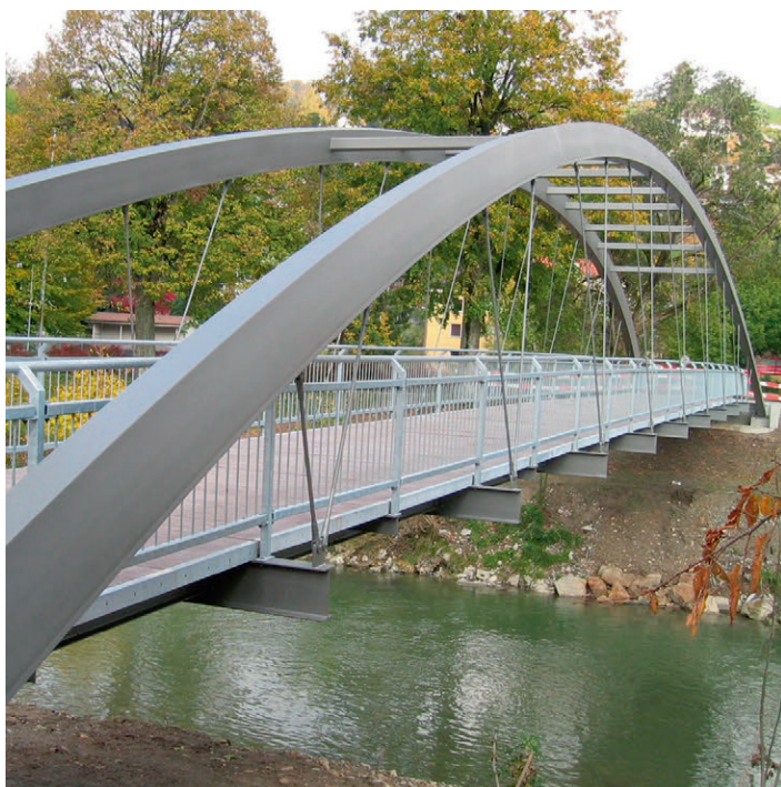
Die Meister Stahlbau AG ist auf die Kaltverformung von Blechen und Profilen spezialisiert.
