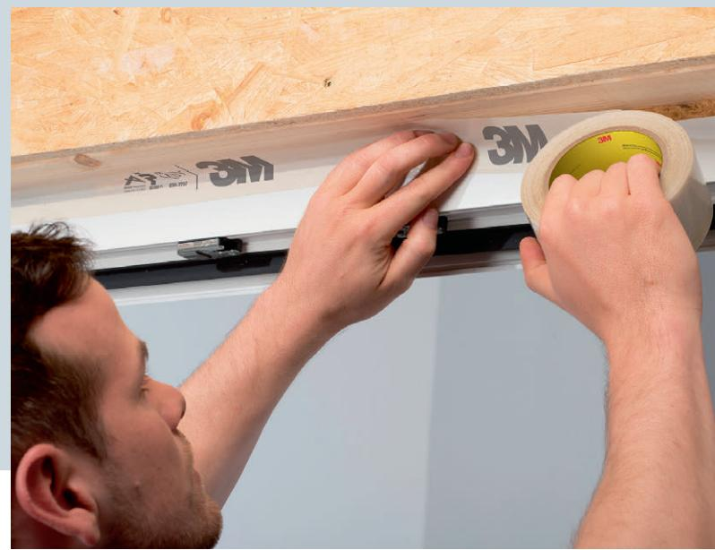
Das Aufkleben von Dichtbändern ist einfacher und schneller als das Abdichten mit Fugenmasse.
