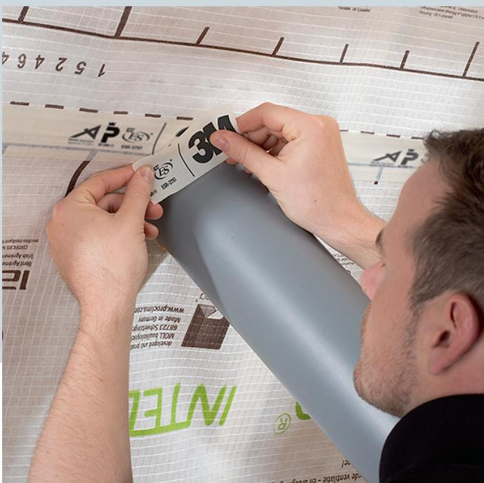
Bei Durchdringungen von Rohren schliessen sich die flexiblen Klebebänder gut an die Form an.
