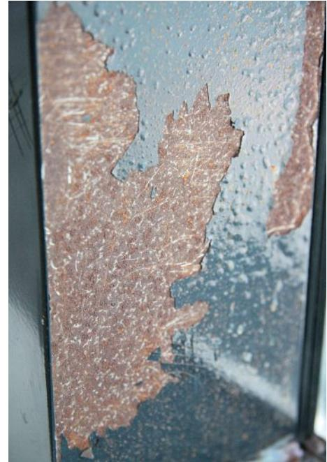
Ein durch Streusalz hervorgerufener hoher Chloridgehalt auf der Unterseite des Lackes führt zu Korrosionsschäden.
