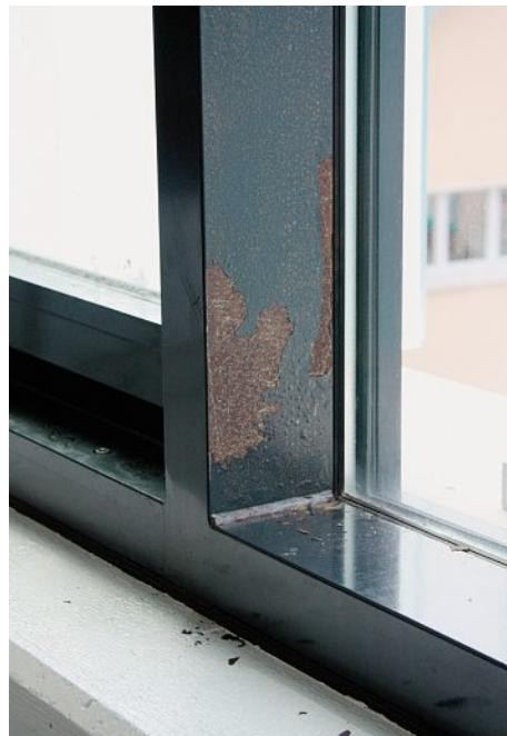
Diese Stahlbauprofile zeigen ein Jahr nach dem Einbau Korrosionsschäden. Finanziell können solche Schäden rasch den Wert des gesamten Werks übersteigen.
