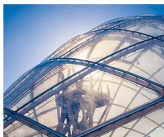
Das Tragwerk besteht aus jeweils zehn Stahlbögen, die sich um eine Längs- und eine Querachse auffächern und so ein Netz aus unterschiedlich grossen Viereck-Feldern spannen. Für diese plante und berechnete formTL eine Überdachung aus vorwiegend zweilagigen ETFE-Kissen, die aufgrund ihrer komplexen Struktur mit zweiachsig gebogenen Profilen befestigt sind. ■
