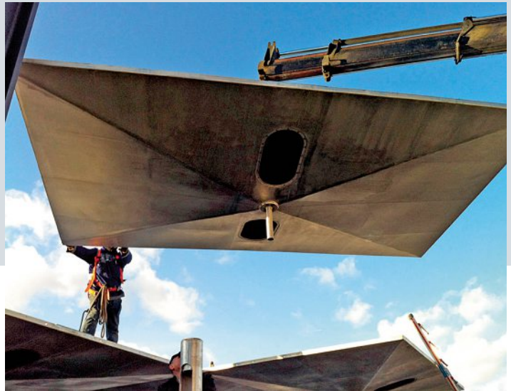
Die Dachelemente werden einzeln an ihre Endposition gehievt. Les éléments de toit ont été hissés un à un en position finale
