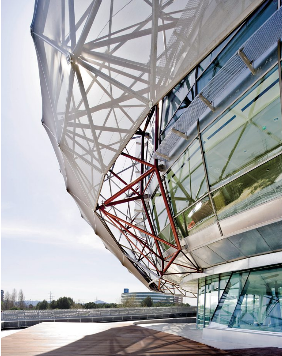
Aussenliegender Sonnenschutz aus PVC-beschichteter Polyesterfolie. Protection solaire extérieure en film polyester revêtu de PVC.
