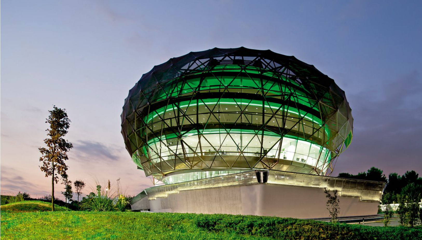
Die Erschliessungsebene trennt den verglasten Baukörper und den unterirdisch angeordneten Bereich auch konstruktiv. Le niveau aménagé sépare le corps de bâtiment vitré de la zone souterraine sur le plan constructif.
