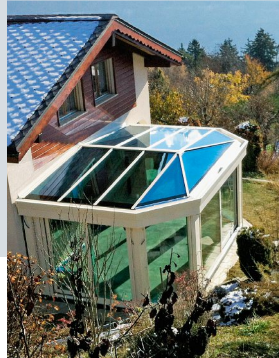
Sicht von oben auf den neuen Wintergarten. Wenig Streben, kraftschlüssige Verbindungen. La véranda vue du dessus. Supports limités et liaisons solides.
