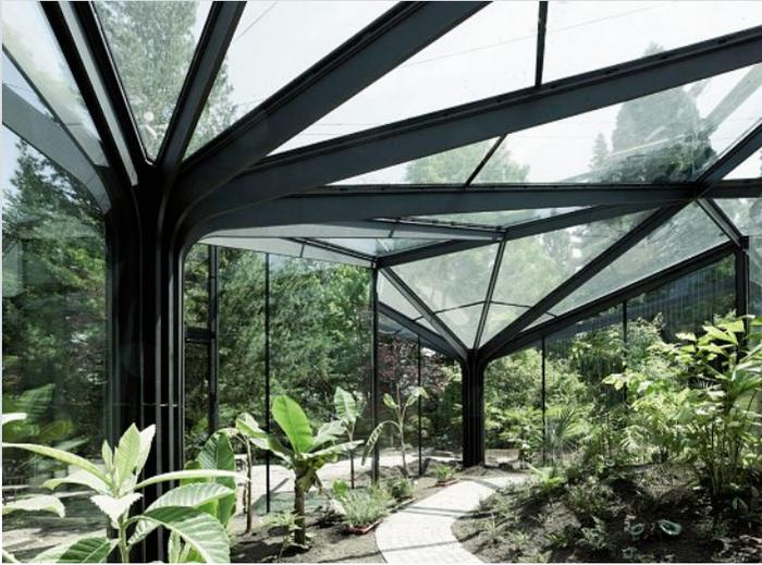
Oben sind die Stahllamellen der Dachkonstruktion mit einem Flachstahl zu einem T-Träger verschweisst.
