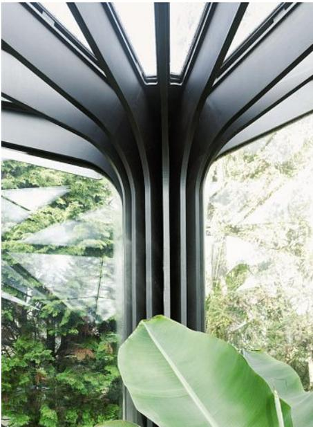
Die Stützen sind aus je 12 Flachstahllamellen mit einer Stärke von 40 mm gefertigt. Chaque poteau se compose de 12 lamelles en acier plat de 40 mm d'épaisseur.
