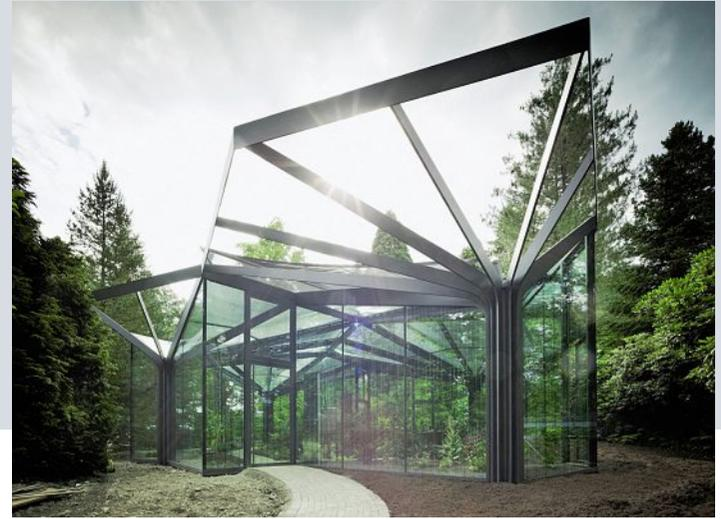
Die Isoliergläser des Daches sind aufgrund der Grösse jeweils in ein trapezförmiges und ein dreieckiges Element aufgeteilt.
