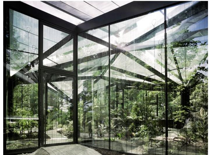
Alle Knotenpunkte sind stützenfrei und für die Glaswände statisch tragend.
