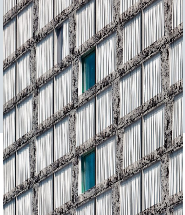
Für die steinerne Optik sorgt ein an den Rändern der äusseren Verbund-sicherheitsgläser aufgebrachter, keramischer Siebdruck. Une sérigraphie en céramique entourant les bords des verres de sécurité composites extérieurs imite la pierre.
