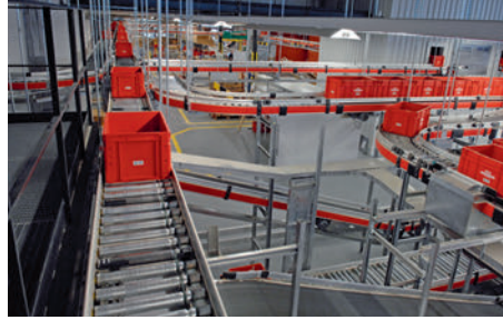
Das riesige Ersatzteillager wird mit dem LowOx-Mess-, Regel- und Analysesystem vor Brand geschützt. Cet énorme entrepôt de pièces de rechange est protégé contre l'incendie par le système de mesure, de régulation et d'analyse LowOx.
