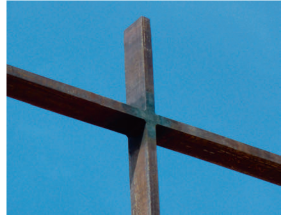
Die vier aufeinanderstossenden Profile sind jeweils in den Spitz gefräst und verschweisst.
