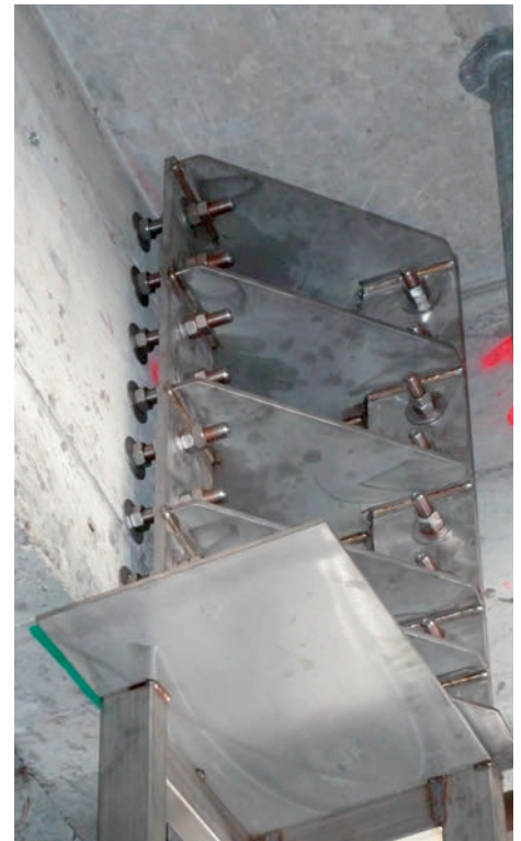
Die innen angebrachte Winkelkonstruktion gewährt eine stabile, die Fassade durchdringende Befestigung.
