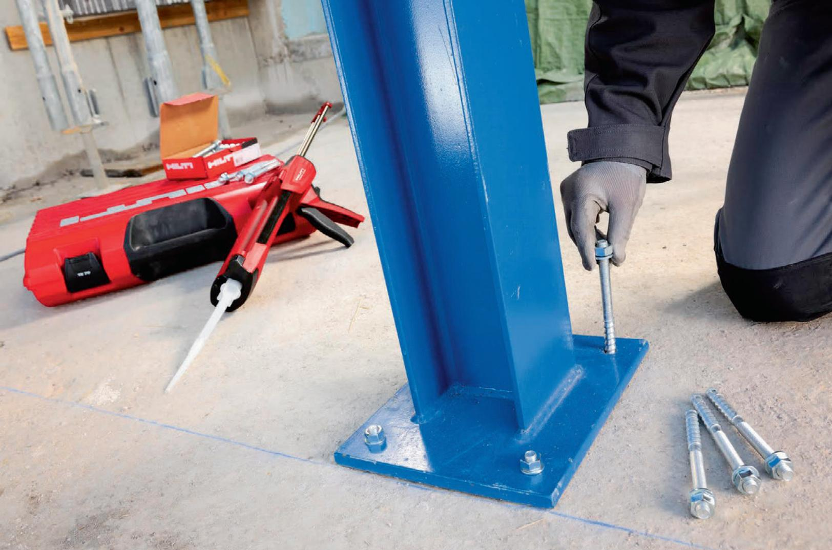
Injektionssysteme, die gemäss Zulassung auch ohne Bohrlochreinigung funktionieren, ersparen den Arbeitsgang der Reinigung, aber auch die Anschaffung und den Transport des speziellen Reinigungswerkzeugs.
