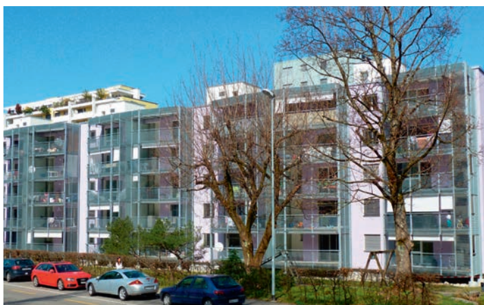
Der neue Fassadenaufbau und die verzinkten Balkonkonstruktionen verleihen der Wohnüberbauung ein frisches Erscheinungsbild.
