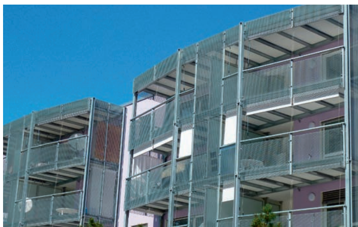
Die Gitterroste sind horizontal ausgerichtet, während die Bodenplattformen ein Gefälle gegen aussen aufweisen.
