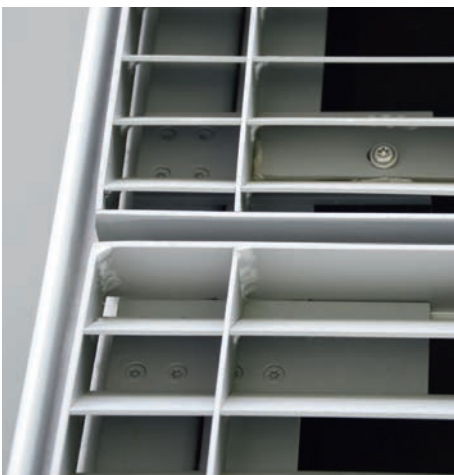
Auch die Montageplatten sind bei einem horizontalen Betrachtungswinkel kaum zu erkennen. Même les plaques de montage sont pratiquement invisibles depuis un angle d'observation horizontal.
