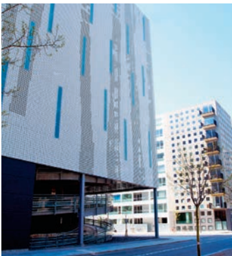
Gelochte Aluminiumbleche von 3 mm Stärke bilden den Fassadenmantel. Le manteau de la façade est constitué de tôles en aluminium perforées de 3 mm d'épaisseur.
