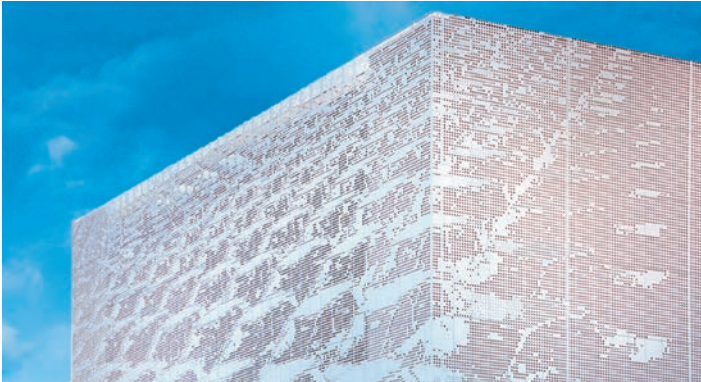
Die Anordnung der Löcher formt das Sujet. La disposition des trous forme le motif.
