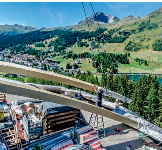
Montage der Dachkuppel-Träger. Montage des supports de la coupole du toit.
