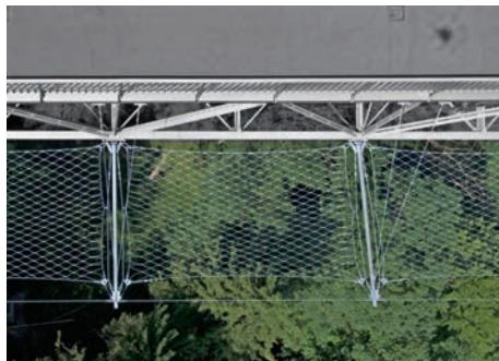
Der verwendete Edelstahl gehört zur Werkstoffgruppe AISI 316 und weist eine hohe Korrosionsbeständigkeit auf.
