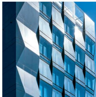
tonische Prägnanz bezieht die neue Vertriebszentrale aus dem Zusammenspiel zwischen klaren kubischen Körpern und der Doppelfassade aus Metall und Glas. Unter anderem mittels der Fassadengestaltung und der begrünten Dachflächen konnte der Energieverbrauch des Neubaus um 30 Prozent reduziert werden, was dem Standard für die Zertifizierung in Silber der Deutschen Gesellschaft für Nachhaltiges Bauen entspricht. ■
