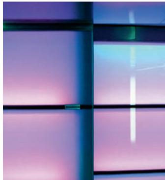
Im geschickten Zusammenspiel von Licht, Glas und Metall gelingt es, eine fröhliche und sichere Atmosphäre im städtischen Untergrund zu erzeugen und die Grenzen zwischen oben und unten aufzuheben. Die mit farbigen und dimmbaren Neonröhren versehene Leuchtwand wird von den Edelstahlflächen der Decke und der gegenüberliegenden Wand reflektiert, flächenbündig hinterleuchtete Streifen in der Decke verkürzen optisch den Weg. ■
