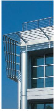
Optimale Lichtlenkung und effiziente Beschattung sind immer häufiger gefragt. WICSOLAIRE-Beschattungssysteme erfüllen diese Ansprüche. Grösse, Montageart und Ausrichtung individuell anpassbar an die jeweiligen Objektanforderungen. Möglich ist eine vertikale oder horizontale Ausrichtung, die Befestigung in Winkeln von 0° bis 45° oder eine bewegliche Montage.
