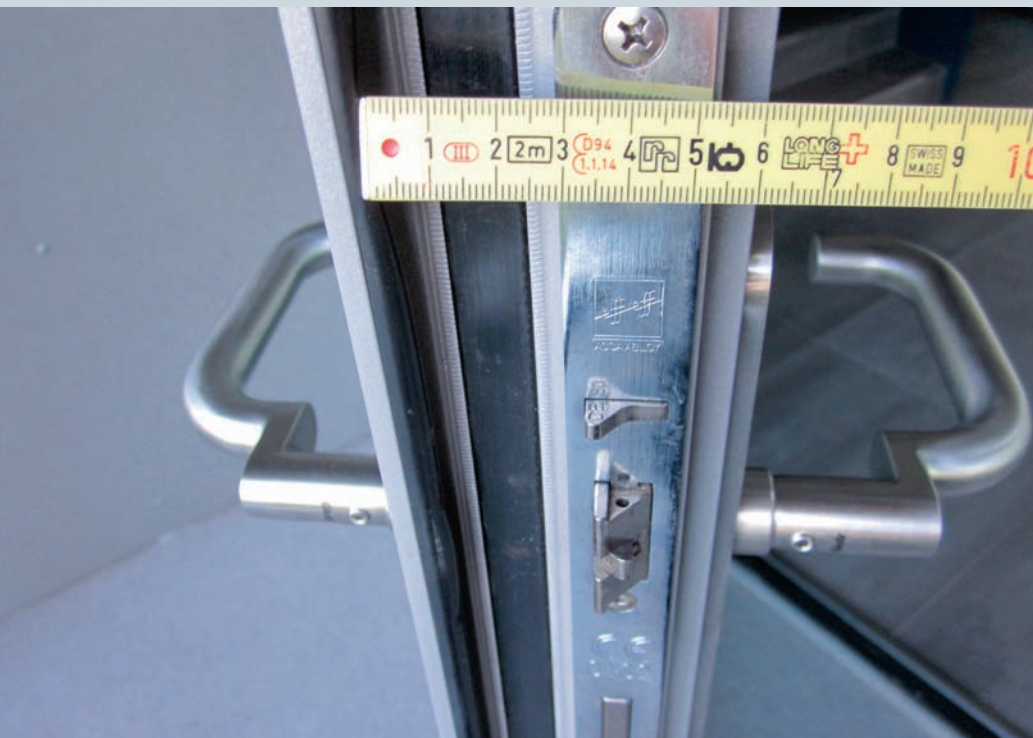
Bild 1 - Aussentüre mit schubfestem Isoliersteg.
