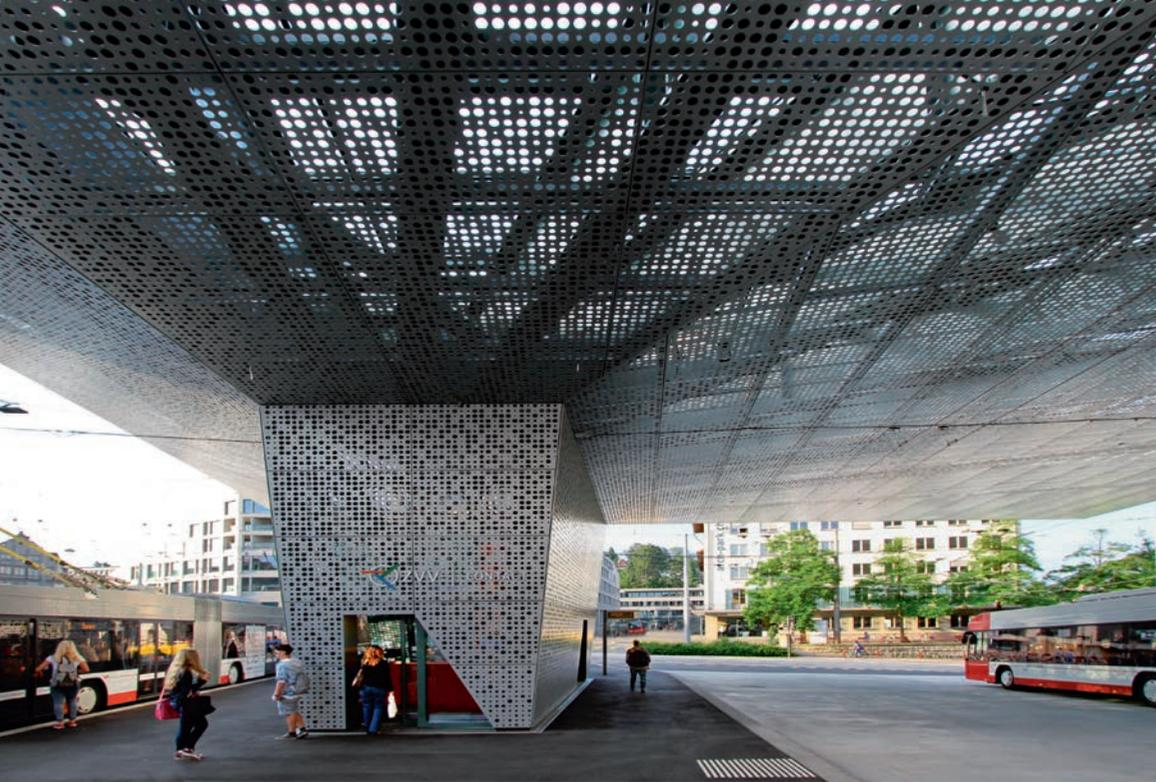
Fünf verschiedene Lochmuster zieren die Bleche. Spezielle Präzision erforderten die schmalen Fugenbilder von lediglich 8 mm.
