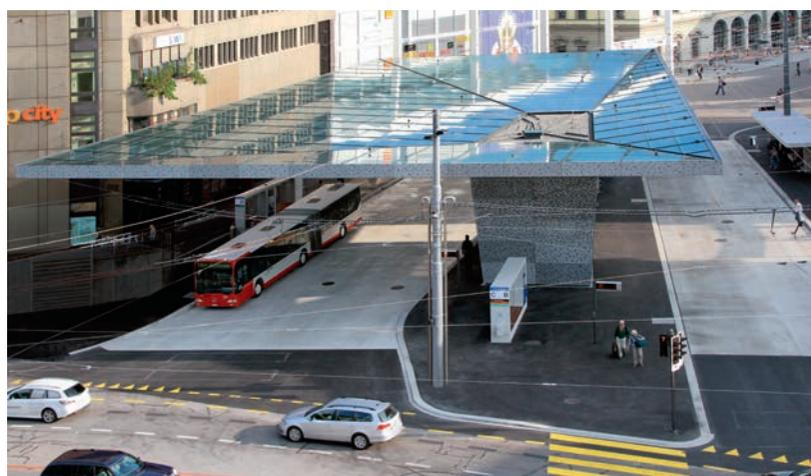
Die obere Dachhaut besteht aus Verbundsicherheitsglas des Typs VSG 16-2, mit einem Gewicht von ca. 50 Tonnen.
