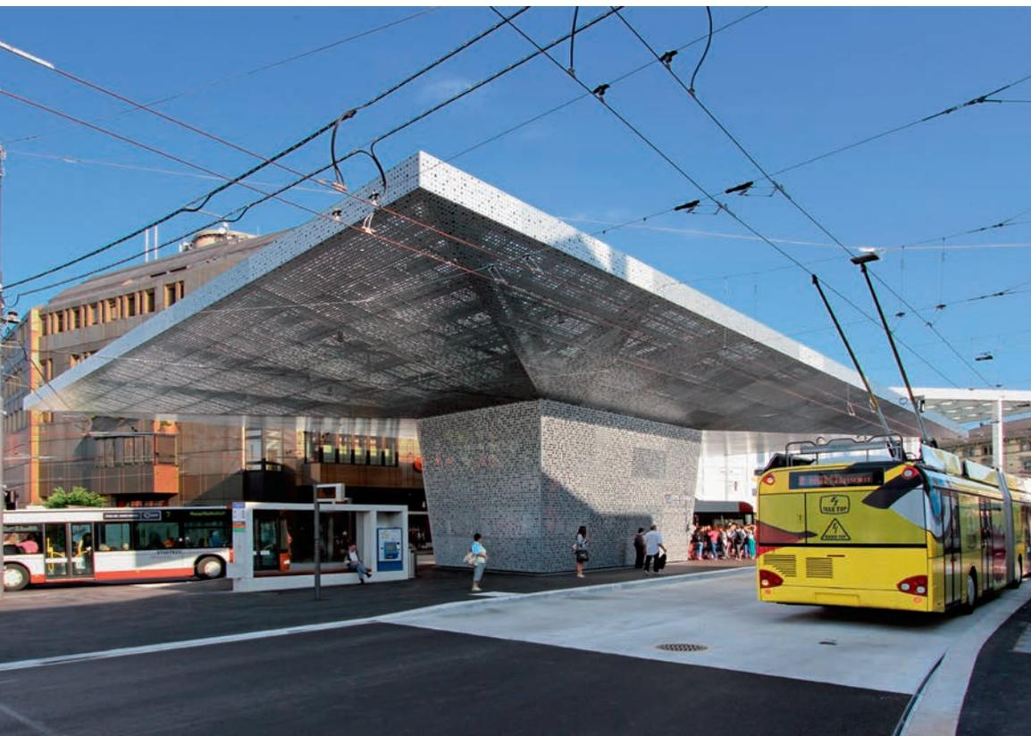
Direkt über dem Fuss - auf Höhe der Untersicht - liegt die 60 Tonnen schwere Kastenkonstruktion. Daran befestigt die Kragträger, von welchen der längste 34 Meter misst. Le caisson de 60 t se trouve juste au-dessus du pied, à hauteur de la sous-face et intègre les poutres en porte-à-faux soudées, dont la plus longue mesure 34 m.
