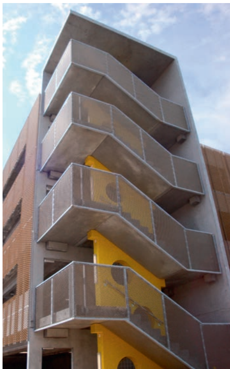
Der Treppenturm hebt sich farblich ab. La cage d'escalier se démarque par sa couleur.
