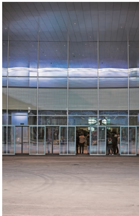
Neben 1200 m 2 Blechflächen verbaute Aepli knapp 5000 m 2 Glas. Aepli a installé 1200 m 2 de surface en tôle et près de 5000 m 2 de verre.
