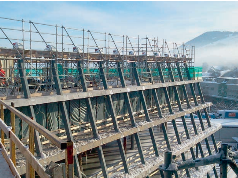
Winterliche Montagesituation. Gut zu erkennen die Stahlstützen des Skelettbbaus. Progression du montage en hiver. Les supports acier de la structure sont bien visibles.
