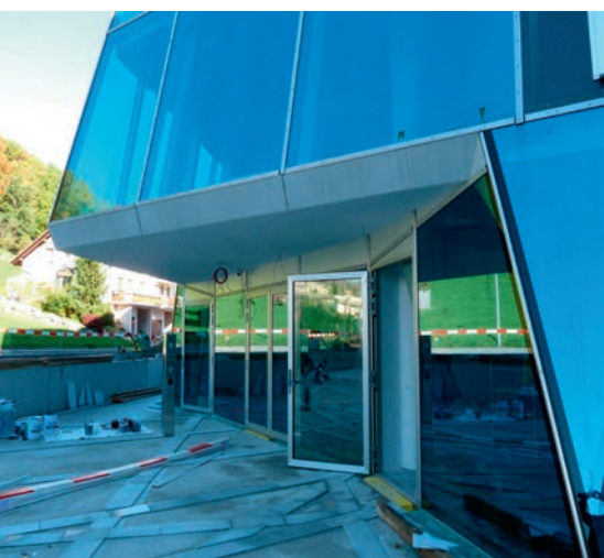
Eingangsfronten im Erdgeschoss kurz vor der Fertigstellung. Kombination aus Pfosten-Riegel-System Schüco FW 60+ und Türelemente System Schüco ADS 70.
