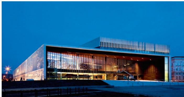
Gesamtlänge von 200 Metern. Um die gestalterische Idee eines «umlaufenden Vorhangs» an der Fassade umzusetzen, ist den eigentlichen Gebäudemauern ein Stahlbetonfachwerk
