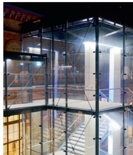
Geschuppte Glasfassade aus 16 mm starkem Verbundsicherheitsglas.
