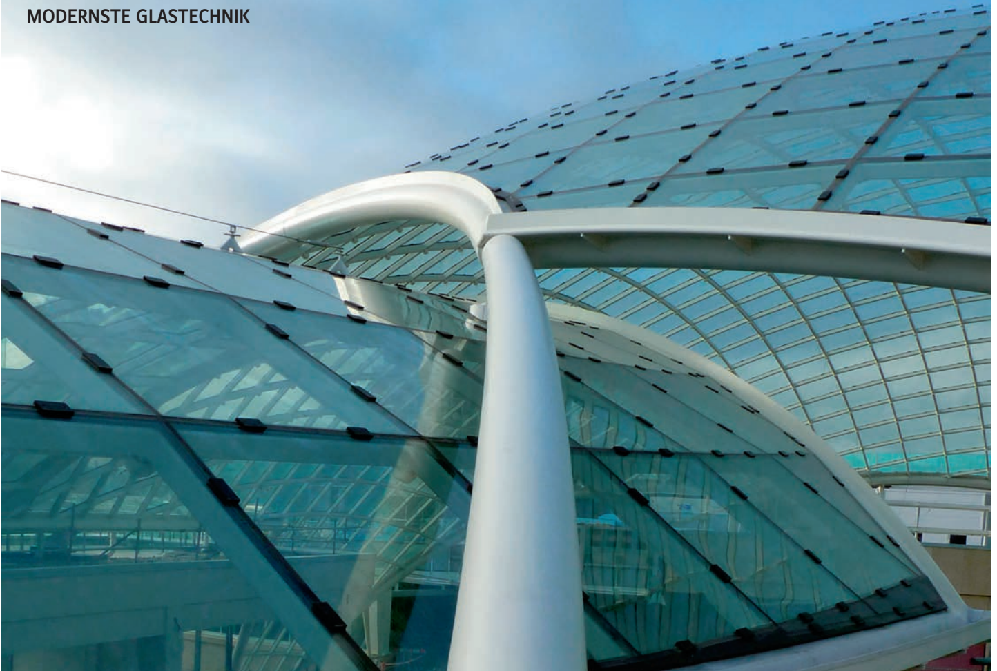
Die gewählten VSG-Gläser bestehen aus planen Vierecken und teils verschobenen Vierecken. Les verres VSG sélectionnés sont composés de rectangles plans et en partie de losanges.
