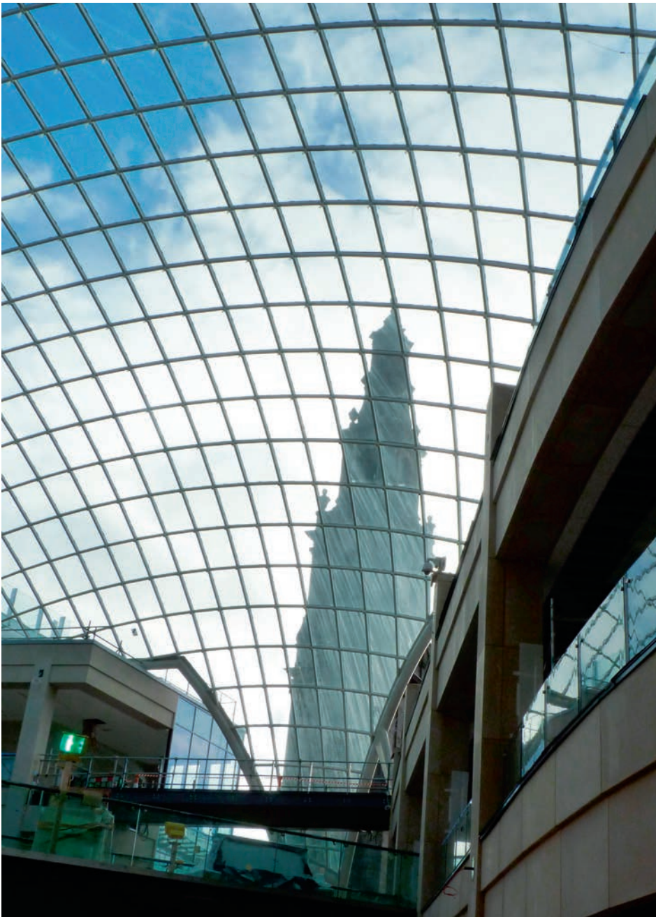
Die Hälfte der circa 3700 m 2 Glasfläche macht die beeindruckende Hauptkuppel über den Platz mit einer Spannweite von 48 Metern aus.
