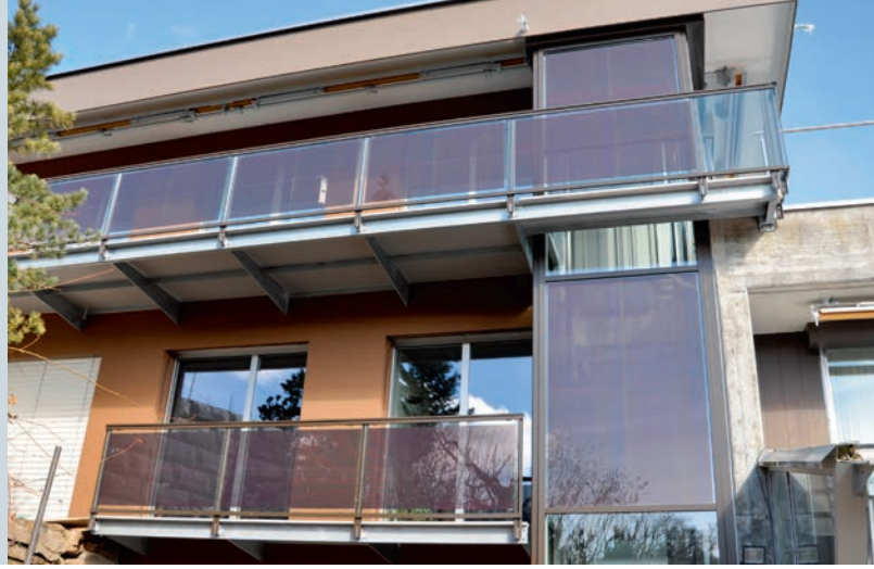
Fassadenelemente und Geländer liefern Sonnenenergie. Les éléments de façade et les balustrades fournissent de l'énergie solaire.
