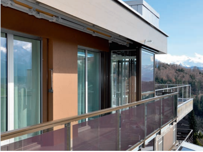
Mit Photovoltaik-Elementen bestückte Geländer. Balustrades équipées de modules photovoltaïques
