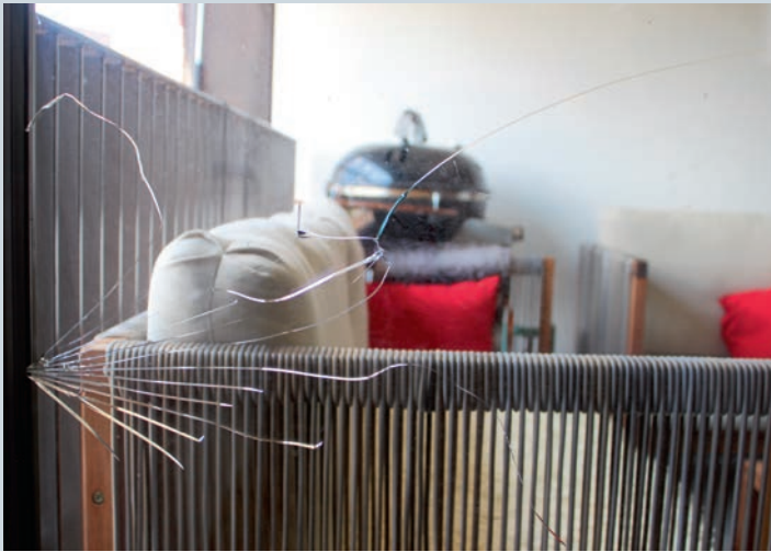
Der Grill im Hintergrund stand vor dem Glasbruch direkt beim Isolierglas. Dessen Benutzung löste den abgebildeten thermischen Glasbruch aus. Avant que le verre ne se brise, le grill en arrière-plan se trouvait directement devant le verre isolant. C'est son utilisation qui a engendré le bris de verre thermique illustré.
