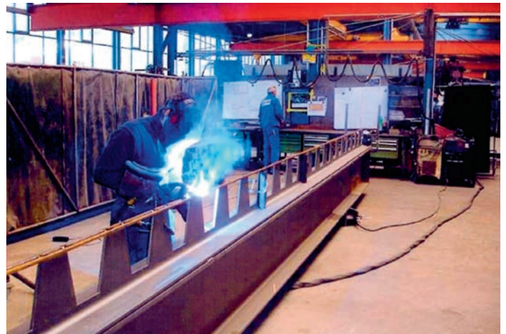
Anschweißen der Längsbewehrung Soudage de l'armature longitudinale
