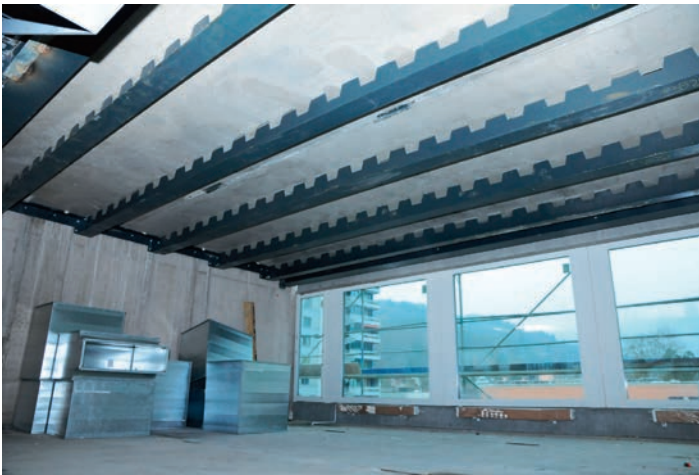
Beim Objekt in Baden ist das Deckensystem in Positivlage eingebracht, d.h. der Beton oben und die Wabenträger unten. A Baden, le système de plafond est posé à l'endroit : le béton est au-dessus et les poutres alvéolaires en dessous.
