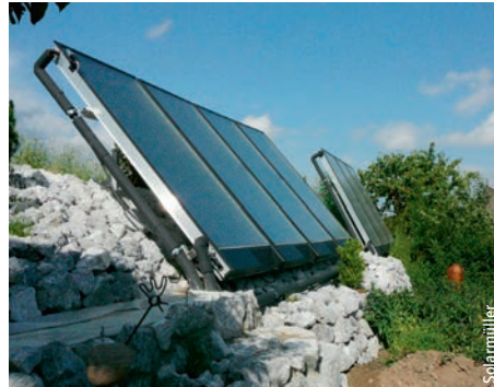
Solare Hybrid-Kollektoren für die Warmwasseraufbereitung.
