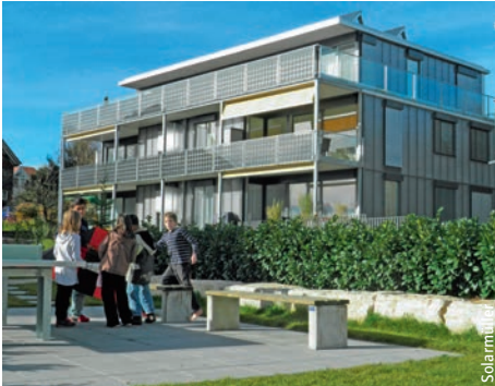
Photovoltaik-Anlage in den Geländern integriert. Solarthermen für die Warmwasseraufbereitung auf dem Dach.
