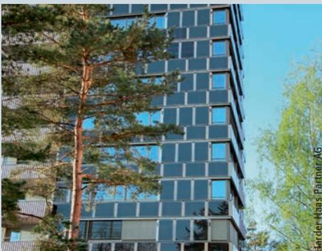
Dünnschicht-Solarmodule aus Silizium (a-Si / nc-Si)
