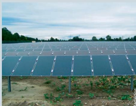
Dünnschicht-Solarmodule aus Cadmiumtellurid (CdTe)
