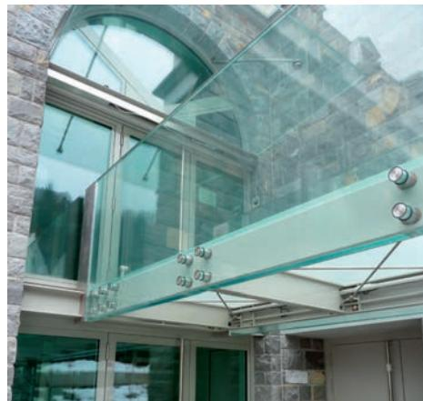
Die beiden Flankengläser übernehmen sämtliche Vertikallasten. Im Bodenbereich sind LED-Leuchtkörper integriert.
