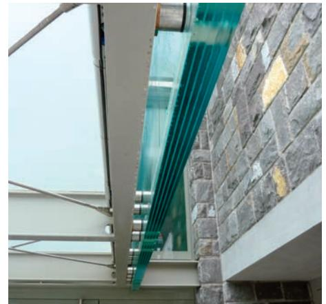
Verbindungen mit speziellen Edelstahl-Glas-haltern.
