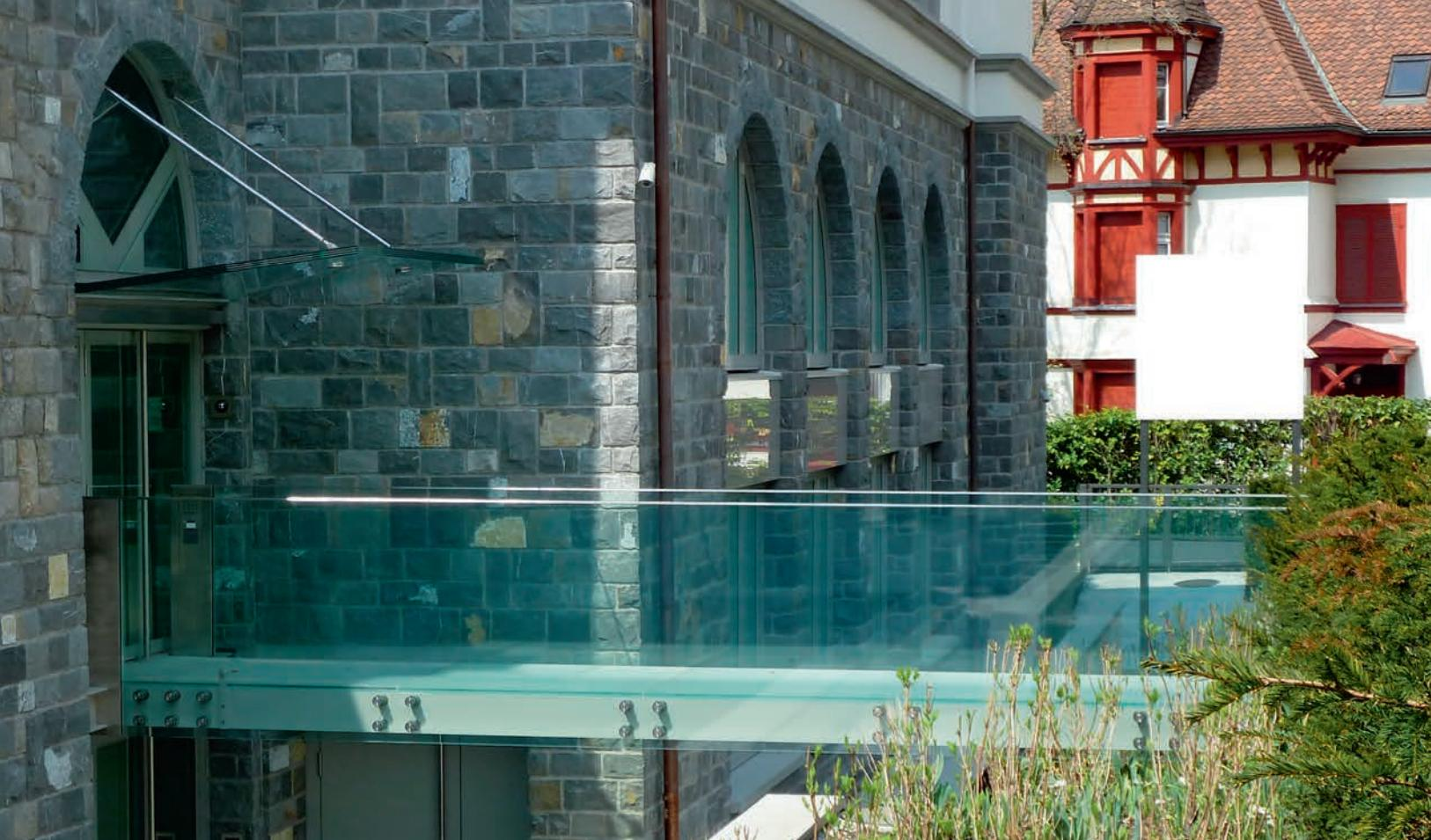
Die Stahl-Glas-Brücke erschliesst einen Nebentrakt der Hotelanlage. Mit integrierter LED-Beleuchtung. Le pont en acier et en verre permet d'accéder à une aile du complexe hôtelier.
