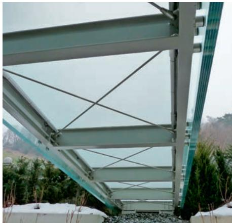
Der Bodenrahmen mit den Windverbänden gewährt die horizontale Aussteifung.
