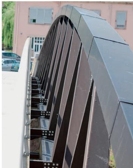
Insbesondere sollte die Brücke einen schönen Bogen und ein schräges Geländer erhalten. Die Konstruktion wurde daher als Fachwerktrögtypus mit schrägen Trägern umgesetzt.
