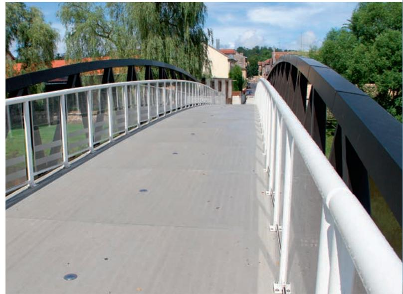
Als Belag wurden polyurethanbeschichtete Aluminiumplattformen eingesetzt, die der Rutschfestigkeitsklasse R12 entsprechen.
