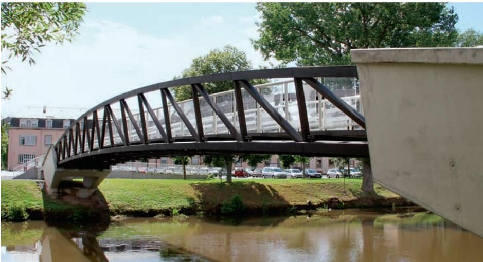
Als Material wurde die Aluminium-Legierung AlMgSi1 verwendet, die den Festigkeitswerten von Stahl S235JR entspricht, gleichzeitig aber um ein Drittel weniger wiegt.
