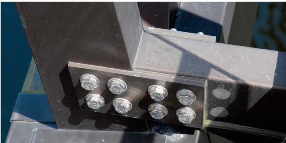
Ein weiterer Vorteil des Materials ist, dass die Brückenteile verschraubt werden und somit auf Schweissverbindungen vorwiegend verzichtet werden konnte.
